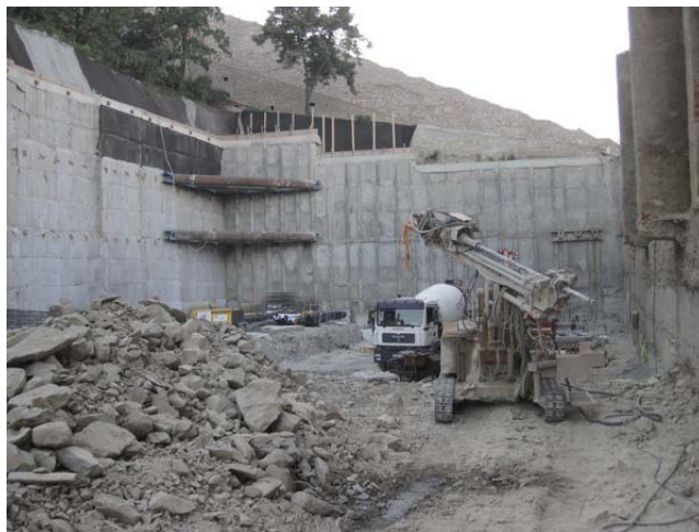
4. ábra. A Várbazárnál kialakítandó mélygarázs a feltárt és már nagyrészt kiemelt márga rétegekkel
