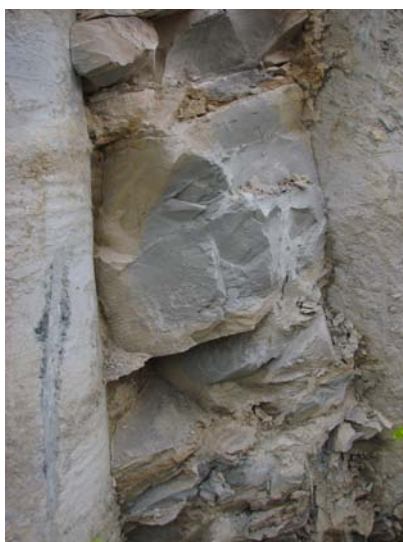
5. ábra. Mintavételi helyszín a Várbazár munkagödrében a cölöpök közötti részből
