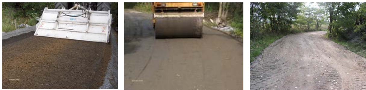
3. ábra. Kísérleti útszakasz építése (Csóke, Mucsi, Sík, 2008)
