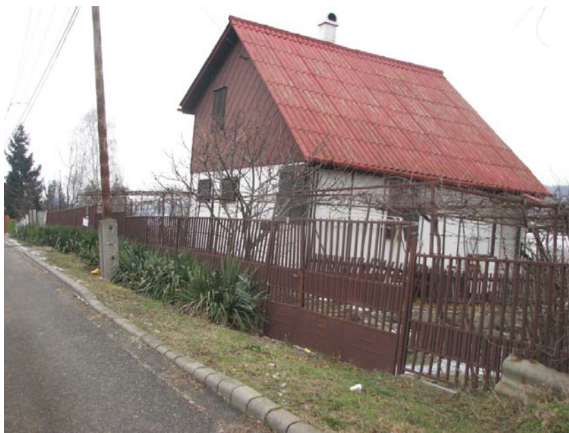
1. ábra. Károsodott ház a Hullám utcában, a ferdülés mértéke kb. 8-10° (2011. január)
