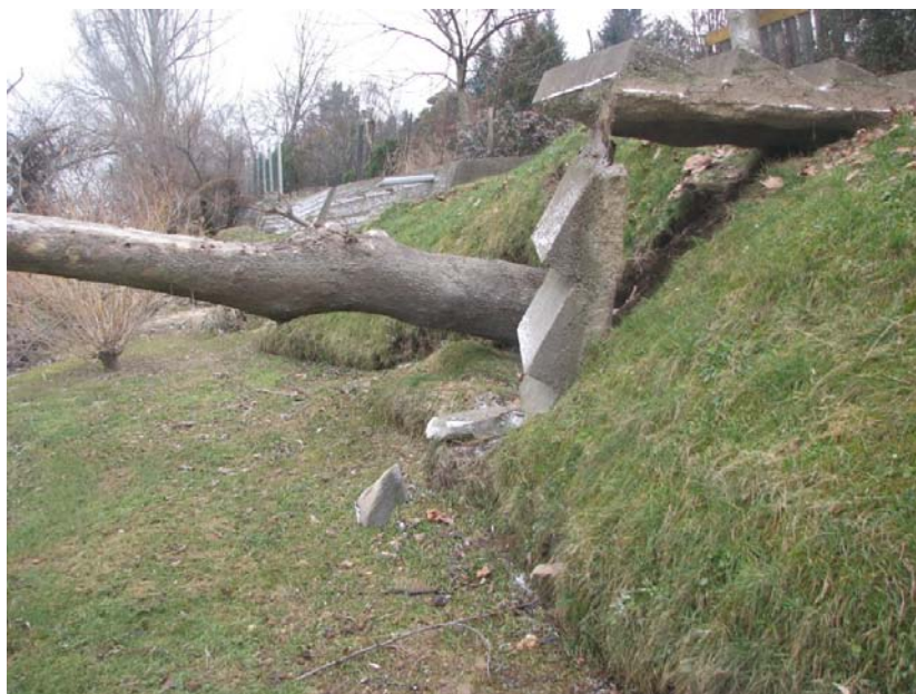
2. ábra. A kidőlt fák, az elmozdult lépcsők és a talaj felpúposodása megmutatja, hogy a tönkremenetel egy sík csúszólapon mentén jött létre (2011. január)
