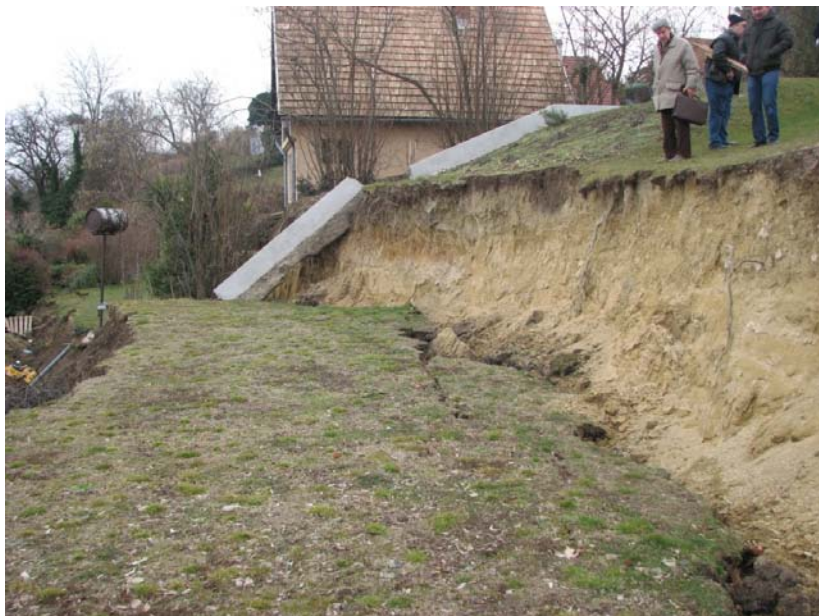
3. ábra. A Sötér sétányon 2010. októberben közel 3 méteres függőleges elmozdulás keletkezett
