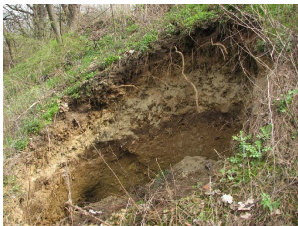
2. ábra. Egy beomlott pince felszíni felszakadása (Collapsed cellar)
