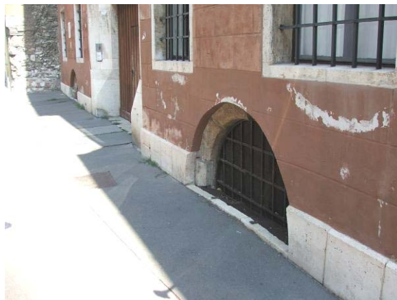
34. ábra. Az Uri utca 31. homlokzatának fotója elötérben a déli szárny lábazatában a kőkeretes pincelejáróval és balról előtte az akna, kürtő jelöletlen vasfedlapja. (A szerző fényképfelvétele 2012-ben.)
