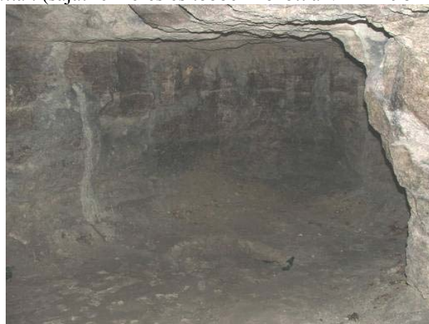
28. ábra. Az Országház utca 2. alatt lévő barlangpince és az alján lévő valószínű kút megsüllyedt körvonala (felette kürtő vagy akna nincs)
