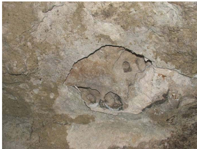
14. ábra. Az Uri utca 16. épület előtti járdaszakasz alatti barlangpince főtéjében statikai vizsgálat során előkerült oldásformák
