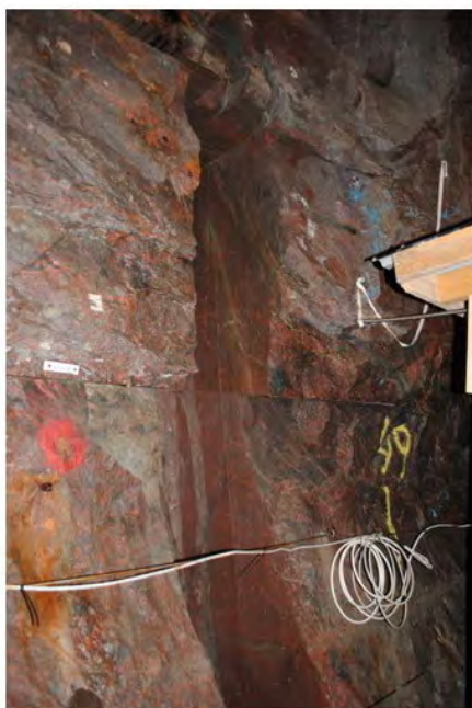
23. ábra. EDZ vizsgálati bevágások gránit befogadó kőzetben, Aspö HRL (Slotting remains in the Aspö HRL)
