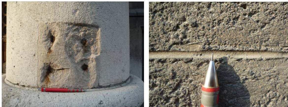
14. ábra a) Fémtüskéről a rozsva lenyomta a pótlást b) Javított felületen a fuga helyét jelképesen jelző kihúzás az "A" falon
