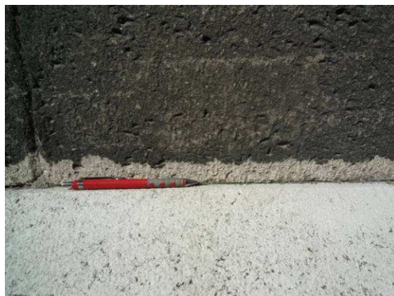
10. ábra a) Sík fekete kéreg, lábazati párkány feletti víz áztatta zóna C falon b) Fekete gömbös kéreg C falon
