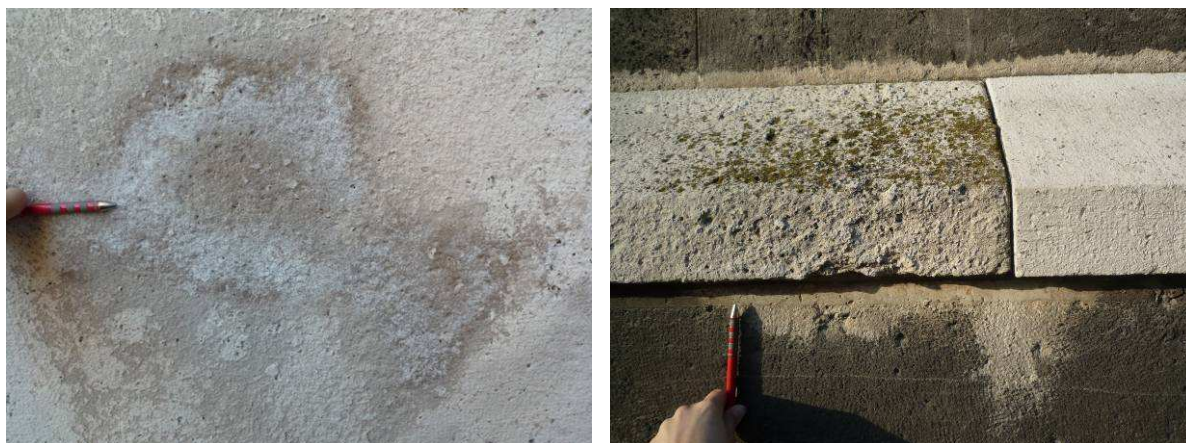
12. ábra a) D falon, nyáron hátról átvizesedett felület sókivirágzást mutat ősszel b) Hiányzó fuga alatti mosott felület a C falon
