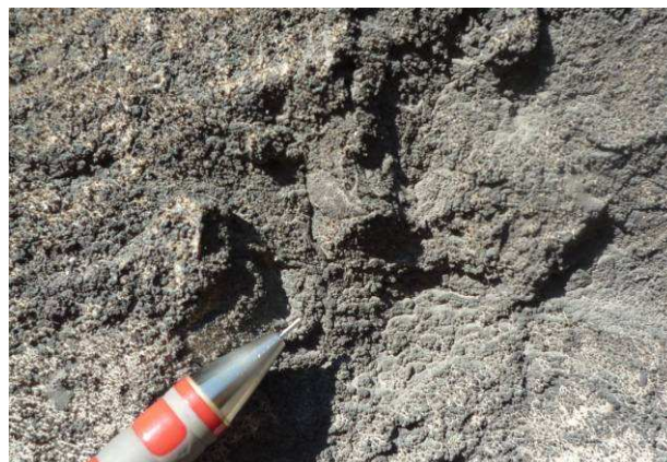
10. ábra a) Sík fekete kéreg, lábazati párkány feletti víz áztatta zóna C falon b) Fekete gömbös kéreg C falon
