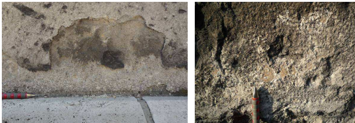
11. ábra a) Szemcseskipergés D falon b) Többszörösen leváló fekete kéreg C falon
