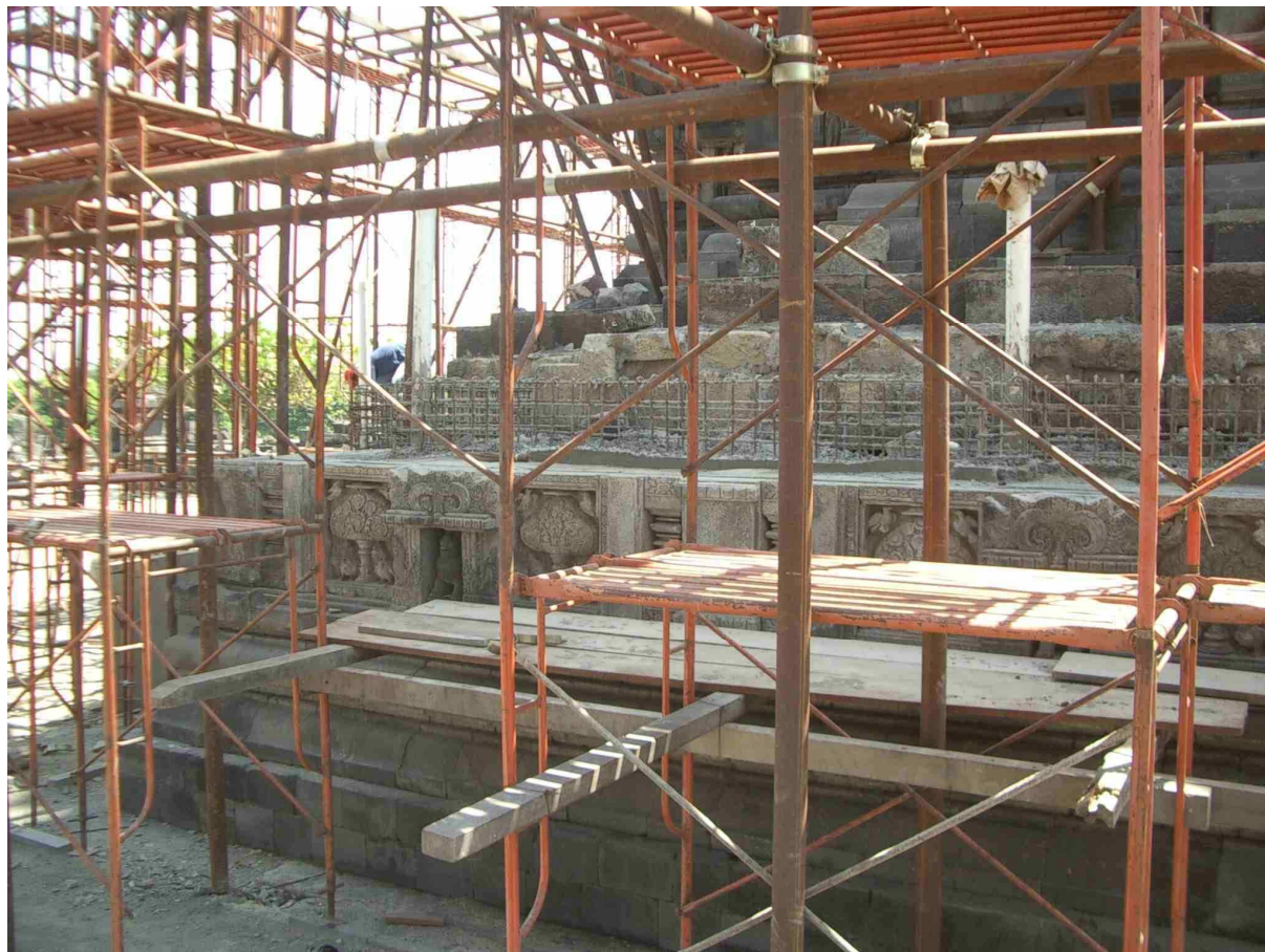
12. ábra. A Visnu-szentély 2008. augusztusában. A puha tufából készült kőmagot – kissé megfaragva – vasbeton köpennyel veszik körül, majd visszaépítik a külső, díszesen faragott burkolatot.
