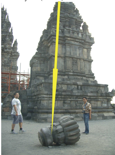
3. ábra. Az Apit Utara-szentély lezuhant csúcscsúcsa. 7,7 m távolságra került, 120° irányban. Fig. 3. Tip of Apit Utara temple fell towards 120° for 7.7 m.
