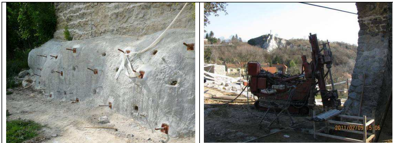
2. kép: Torkrét falazat talajszegezéssel
