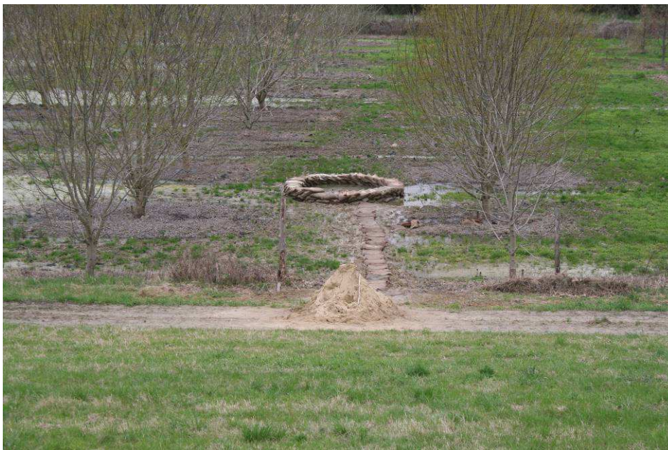
2. kép Dombori buzgár a gátkoronáról (2006). A talaj kimosódás mintegy 20 méterre a töltéslábtól keletkezett. (5-8. sorszámú terület az 1. és 2. táblázatban)
