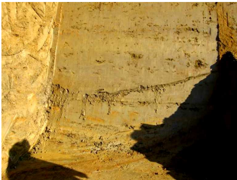
8. ábra: Vékony rétegekben megjelenő szivárgó víz
