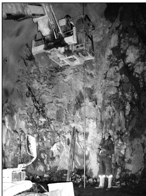
4. ábra. Konvergenciamérés kivitelezése Bátaapátiban, 33 m 2 -es vágatszelvényben (jobbra)
