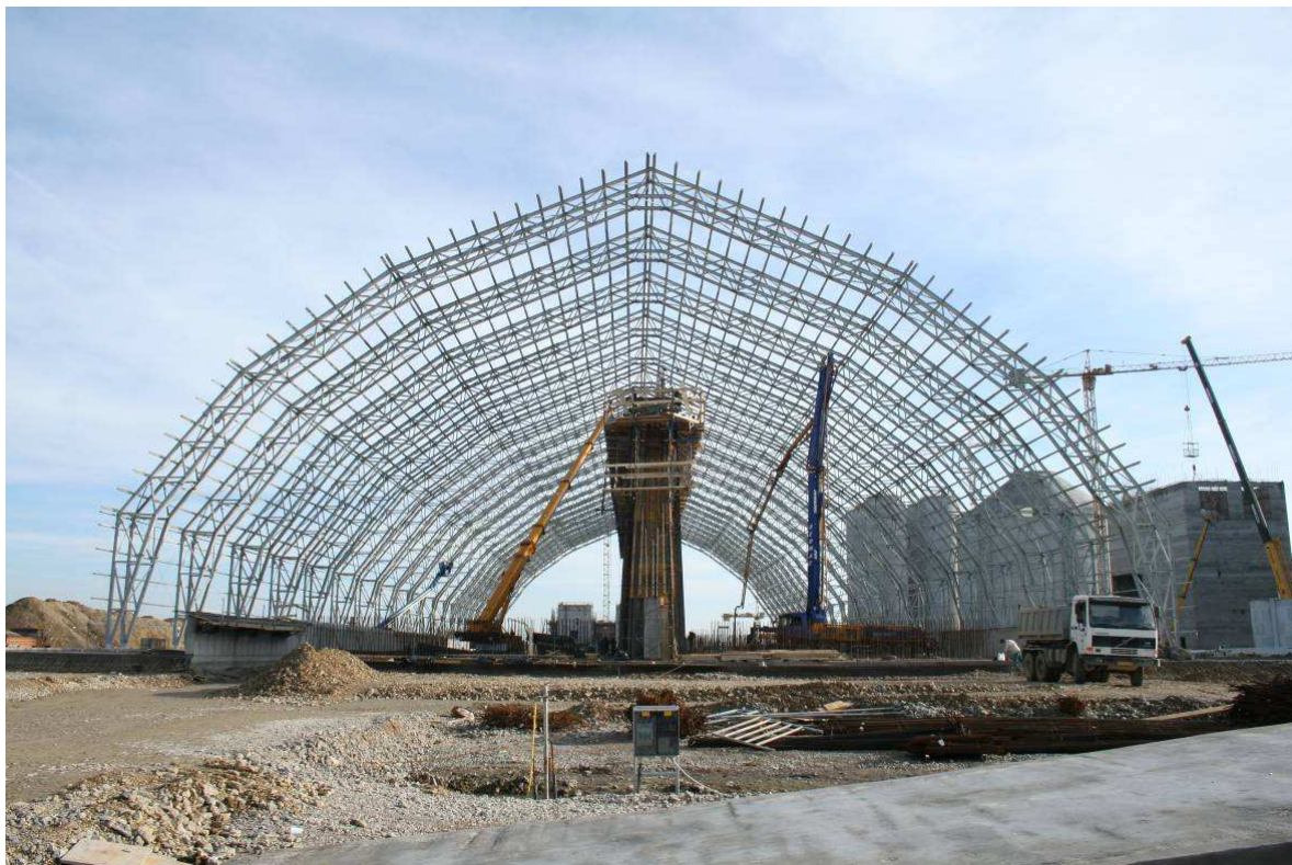
9. kép: Nyersanyagtároló csarnok kivitelezés alatt - 2009. november
