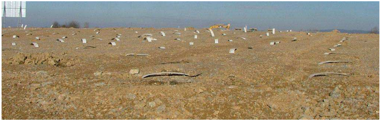
7. kép: Elkészült szalagdrénezés
