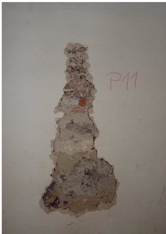
3. ábra. Feltárás hosszú függőleges sávban
