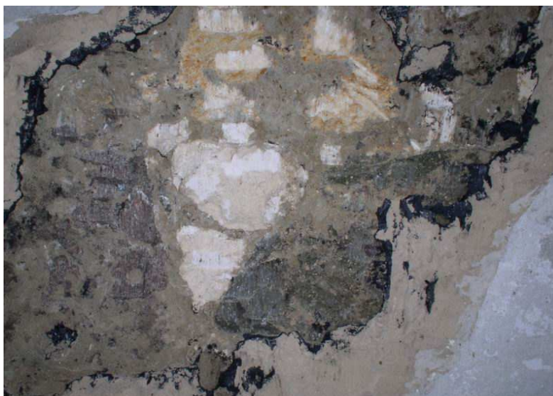
7. ábra A falazatban vegyesen előforduló durva mészkő (világos) és andezittufa (sötét) kőzetdarabok pince falazatban
