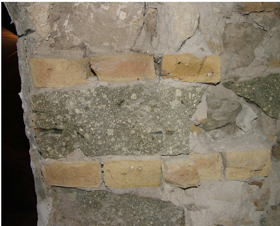
2. ábra. Pince szinti pillér vegyes falazatból, szabályosan váltakozó kő (mészke és andezittufa) és téglá sorokkal
