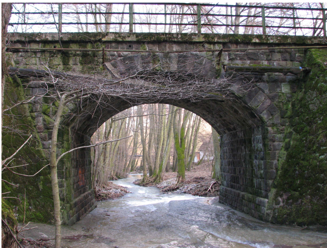
1. ábra. A híd oldalnézete a befolyási oldalról
