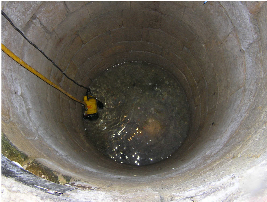
2. kép. A Nagy kút szivattyúzása
