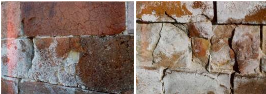
5. ábra. Egri várszékesegyház későgótikus része. a) égési kéreg a riolittufa anyagú pilléren b) falazat károsodása és elszíneződése
