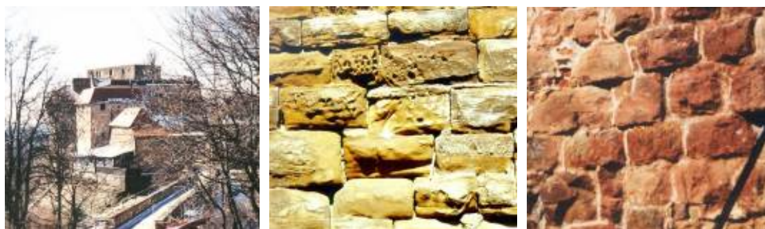
1. ábra. Hohenrechbergi vár (Hajpál 1995). a) az épület látképe b) mállott homokkő fal c) égett és mállott homokkő fal
