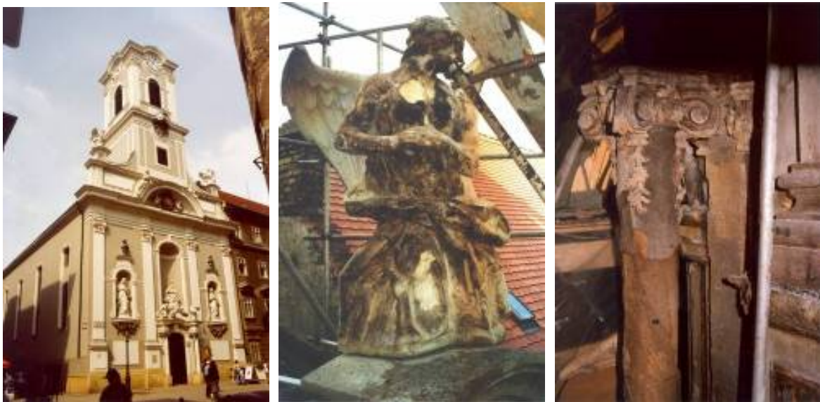
4. ábra. Szent Mihály-templom. a) az épület látképe napjainkban b) sérült angyal szobor a tűz után c) tűz okozta leválás és elszíneződés egy oszlopon
