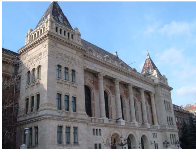
6. ábra. A BME Központi épületének főhomlokzata a szilárdulást követően dolgozták ki a kőfelületet
