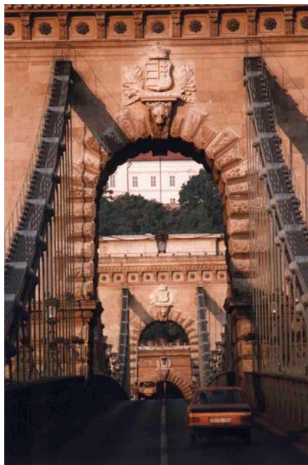
4. ábra. Lánchíd, címer előre gyártott pótlás
