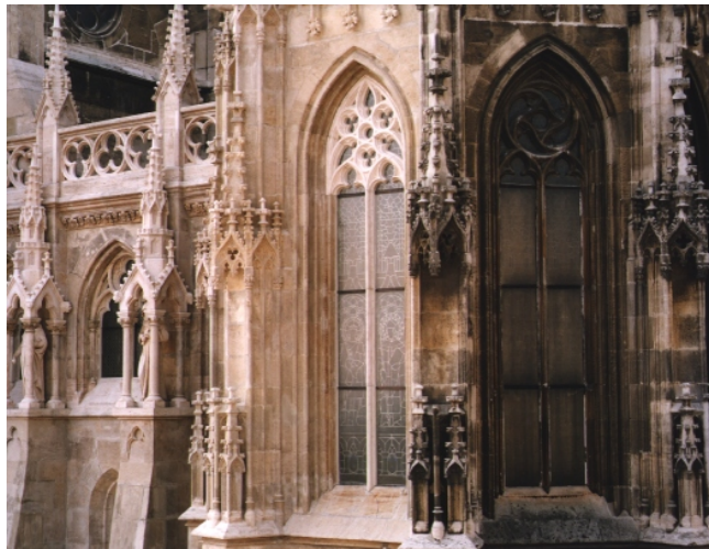
7. ábra. Mátyás-templom felújított (letisztított, újra fugázott) és a még felújításra váró homlokzati kőelemei
