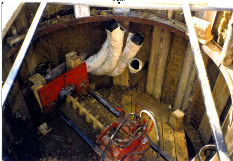
4. ábra A vízvezető rendszer építése. Szakaszosan toldott acélcsövekkel és fűréssal, majd a 200 mm-es acélcsőbe befűzött 160 mm átmérőjű bordázott draincsövekkel kialakított 16-24 m hosszú vízvezető csövekkel.
