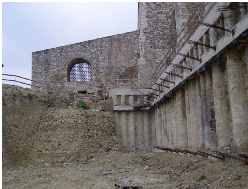
13. ábra. A munkagödör É-i végén a cölöpsor és a horgonyok mellett még szálban álló cementált mészmárga és agyagmárga váltakozásából álló rétegsor látható
