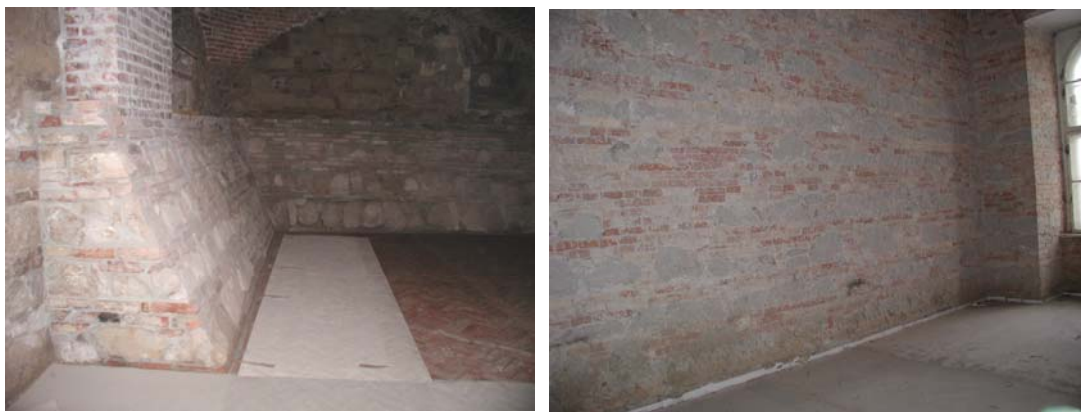
2. ábra. Vegyes anyagú alapfal a budapesti Sándor Palotában és vegyes anyagú falazat az esztergomi volt Érsek Papnevelde épületében
