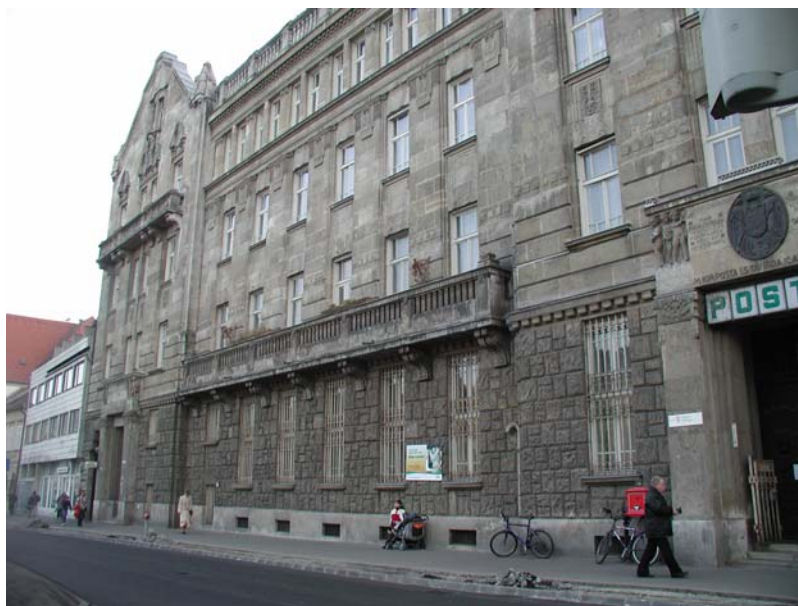
4. ábra. A soproni Posta Palota durva mészkővel készült vegyes falazata
