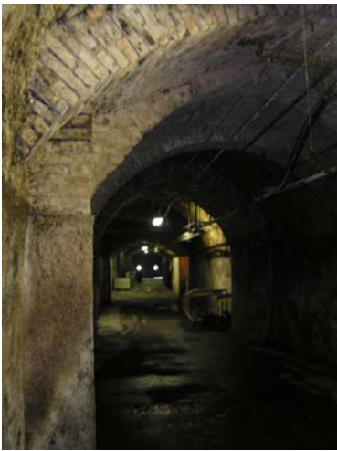
8. kép Téglafalazattal, boltívvvel megerősített járat villanyvilágítással (Éles sarok)
