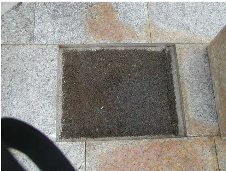
9. ábra. Száraz és nedves ágyazati zúzottkő a megjelenő kioldódó vasoxidos kiválással.
