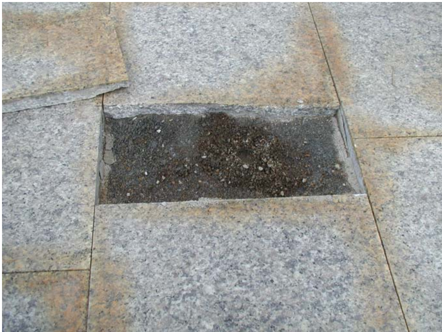
5. ábra. A burkolólapok szélein megjelenő vasoxidos kiválás.
