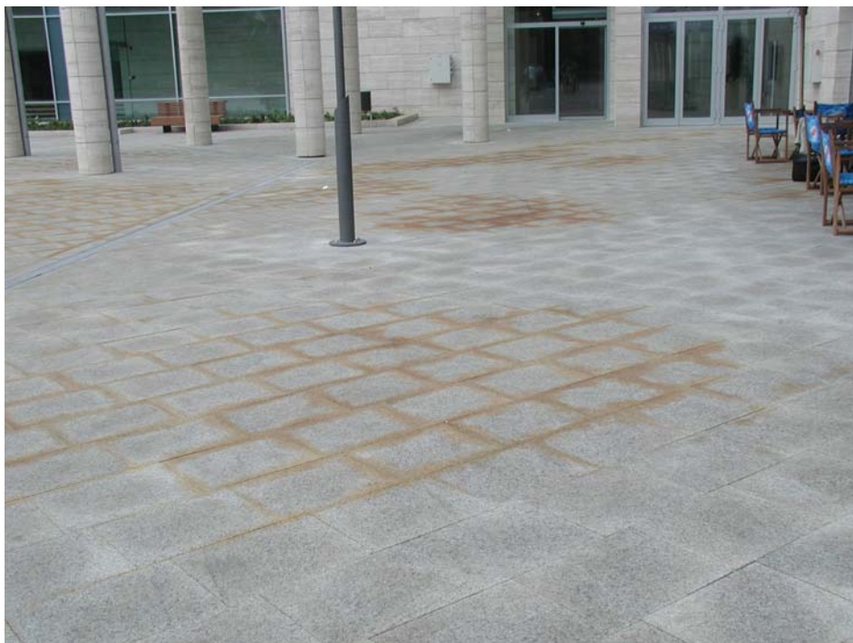
3. ábra. Rozsdafoltos elszíneződések a díszburkolat egyes mezőiben.
